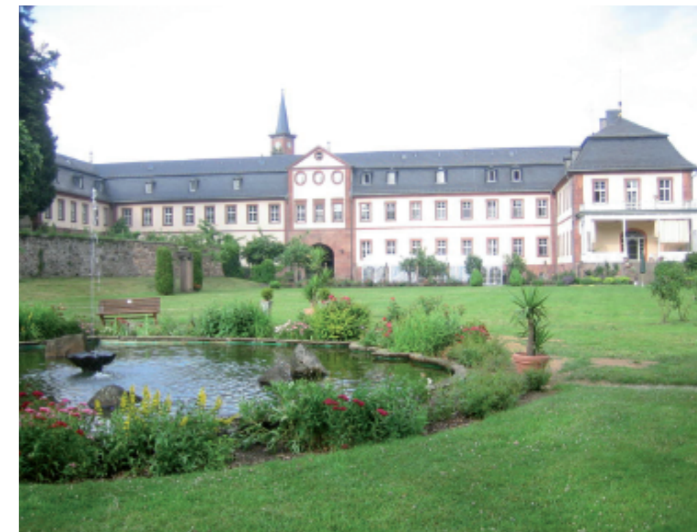
Schloss in Herbstein-Stockhausen versorgt durch ein Nahwärmenetz mittels Biomasse unter Anwendung der Kraft-Wärme-Kopplung Palace in Herbstein-Stockhausen supplied via a district heating grid using biomass and combined heat and power generation
